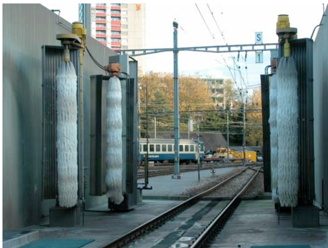
Lokdepot BLS, Zugwaschanlage Aebimatte
